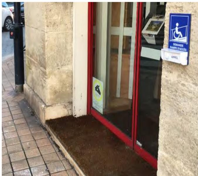
**/ Attention :** il faut un dispositif d'appel pour que le personnel vienne mettre en place la rampe : une sonnette accessible à une personne en fauteuil roulant, avec panneau de signallement placé entre 0,90m et 1,30m du sol.
