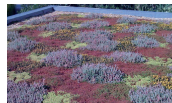
toiture terrasse végétalisée
