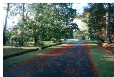
voirie et fossés latéraux
