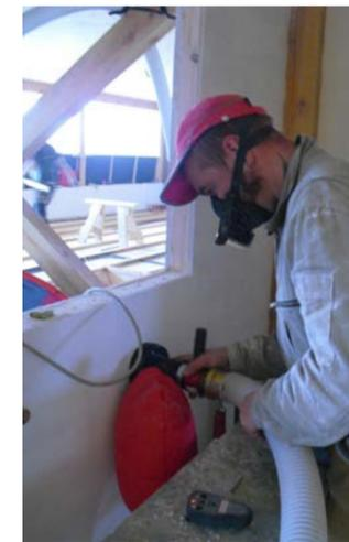
**Soufflage horizontal** en comble ou en plancher : réalisé également dans des caissons constitués par les solives de plancher. L'application se fait en posant la buse de soufflage au sol pour faire monter l'isolant de façon à lui faire prendre la densité requise, l'avantage est également de ne pas provoquer de poussière (ce qui se produit obligatoirement en cas « d'arrosage » de la zone à isoler).
