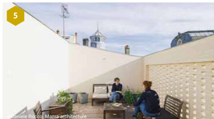
5 - La chaux trouve également sa place dans les projets actuels. Dans cette surélévation (Bordeaux), la chaux est utilisée pour la terrasse et le moucharabieh avec un profil très moderne.
