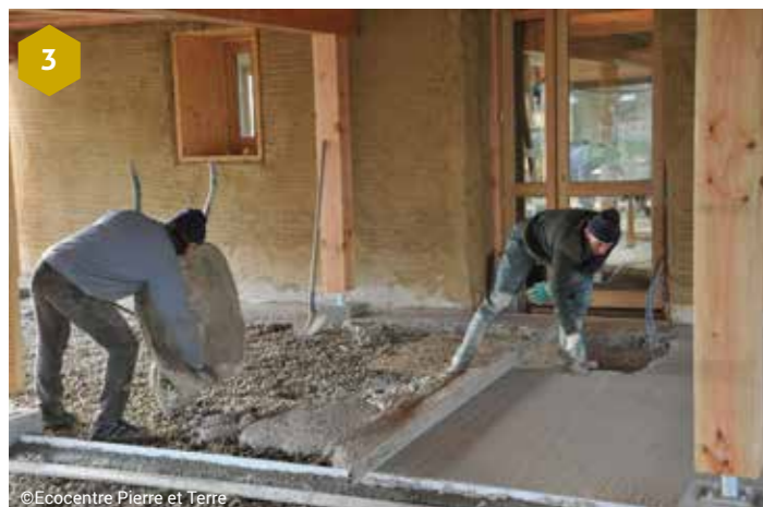
3 - La chaux, aussi efficace sur murs extérieurs que pour la composition de dalles (projet de l'Ecocentre Pierre et Terre dans le Gers.)
