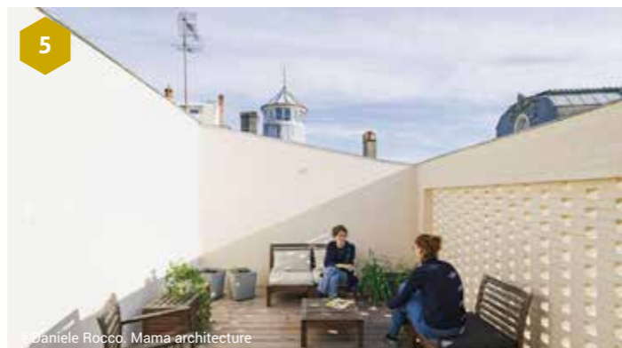
5 - La chaux trouve également sa place dans les projets actuels. Dans cette surélévation (Bordeaux), la chaux est utilisée pour la terrasse et le moucharabieh avec un profil très moderne.
