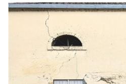
Fissures et joints abîmés : points d'entrée pour l'eau de pluie.
