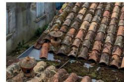
Infiltration par le toit : dégradation des isolants et de la toiture.
