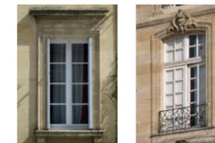
Si le remplacement complet est inévitable, le matériau approprié est le bois. Il est naturellement isolant donc particulièrement adapté pour les portes pleines, les fenêtres, les volets battants, etc.
