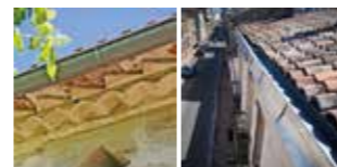
gouttière pendante chéneau encastré
