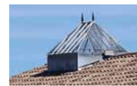
verrière sur une cage d'escalier
