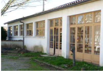
Façade nord de l'école
